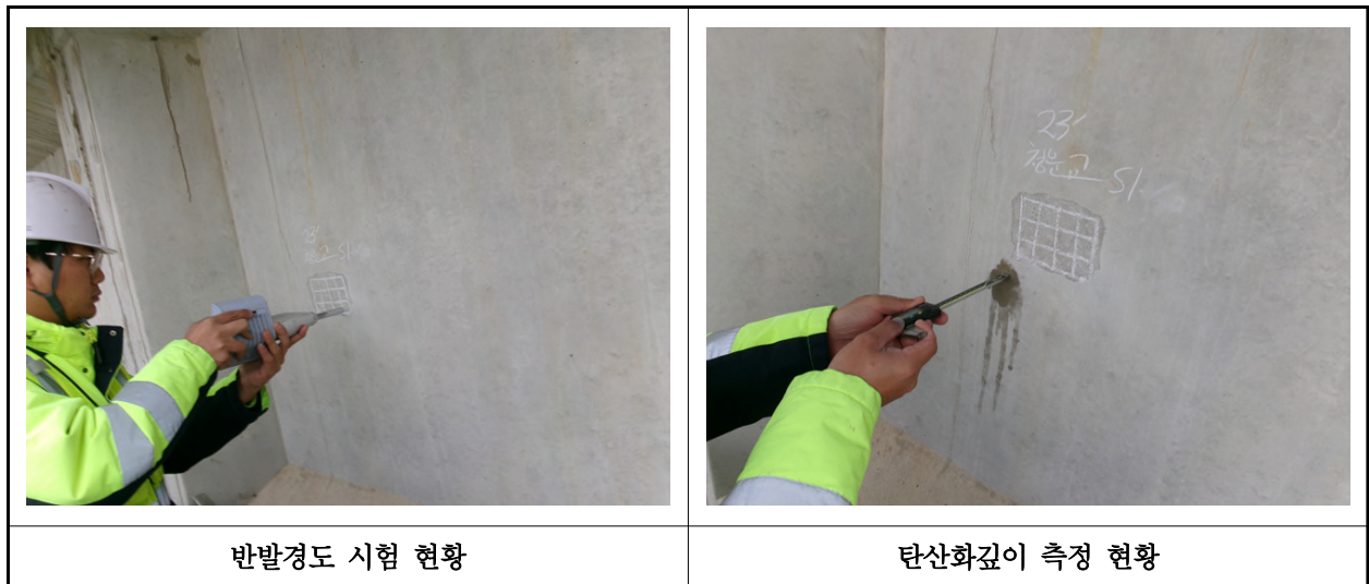
【사진 3.4.1】 콘크리트 내구성조사 현황
