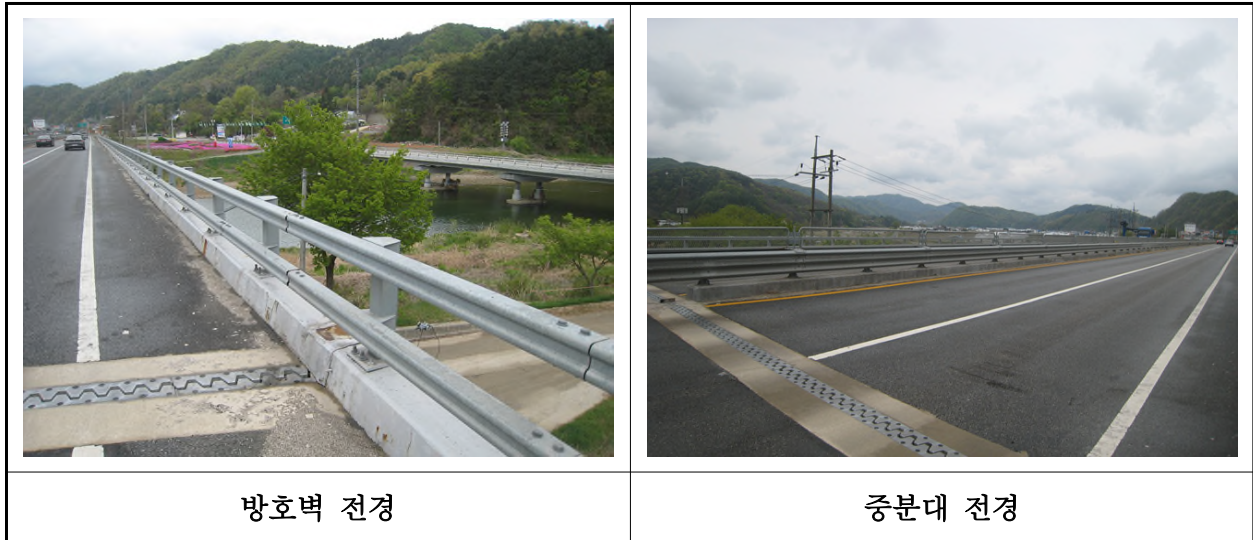
【사진 3.3.23】 방호벽 및 중앙분리대 전경
