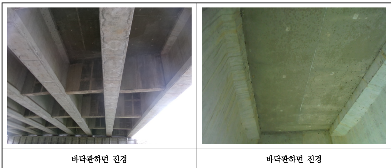
【사진 3.3.2】 바닥판하면 전경
