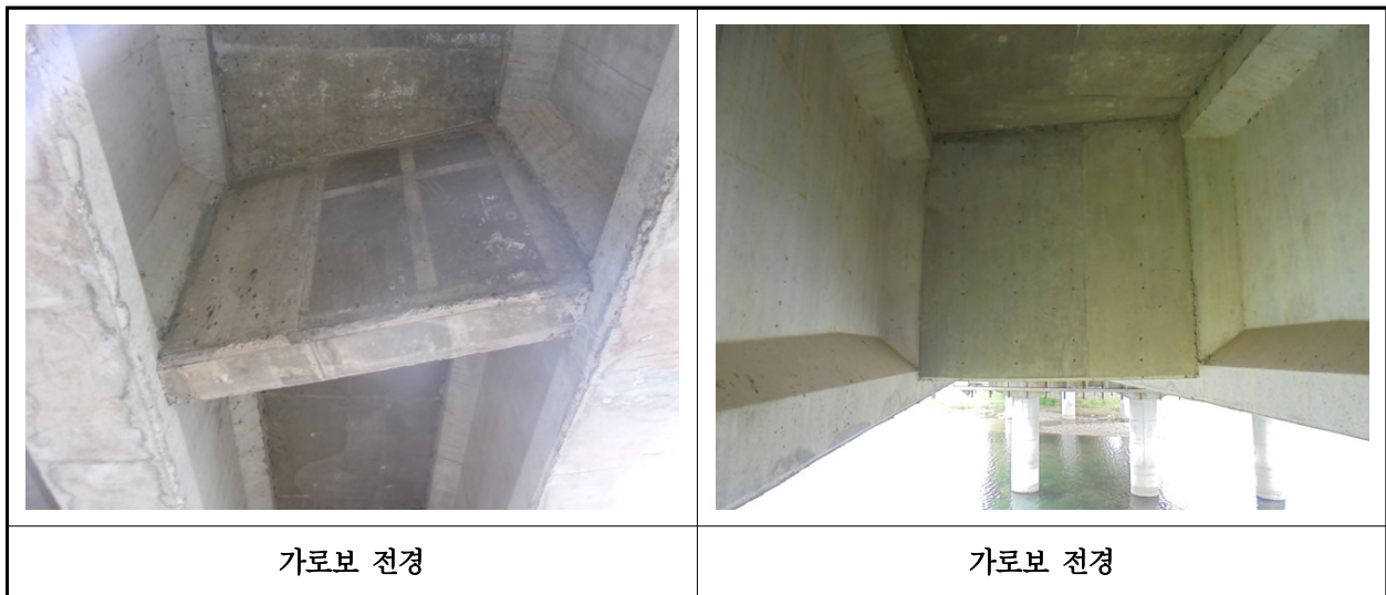
【사진 3.3.6】 가로보 전경
