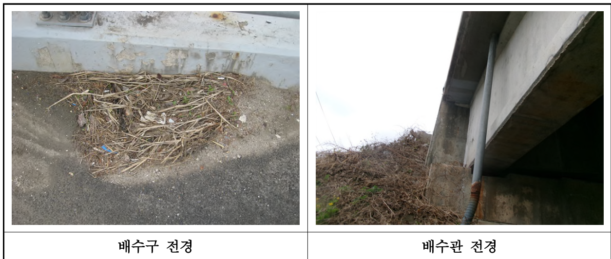
【사진 3.3.21】 배수시설 전경
